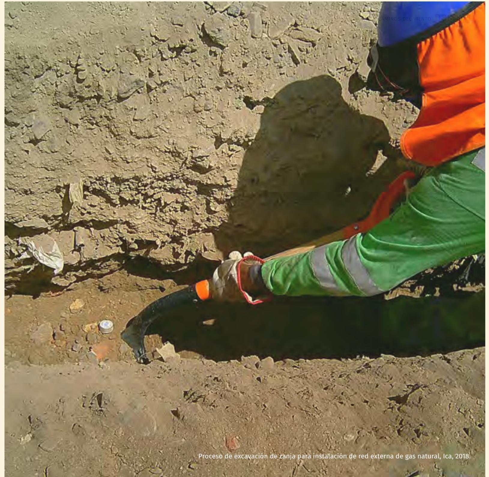
Proceso de excavación de zanja para instalación de red externa de gas natural, Ica, 2018.
